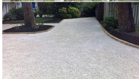
Exemples de revêtements perméables adaptés aux stationnements (dalles alvéolées enherbées – gravillonnées – calcaire compacté).
